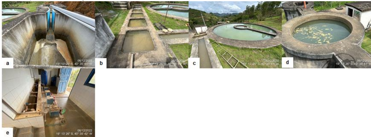
Figura 14: Vistas da ETA Novo Brasil: a) Calha Parshall; b) Floculadores; c) Decantadores; d) Filtros; e) área de desinfecção.
