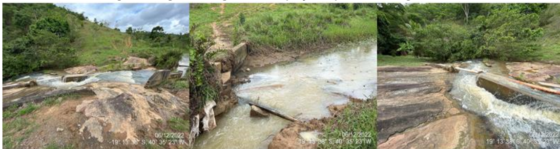
Figura 9: Registro Fotográfico da captação superficial Córrego Paraíba.
