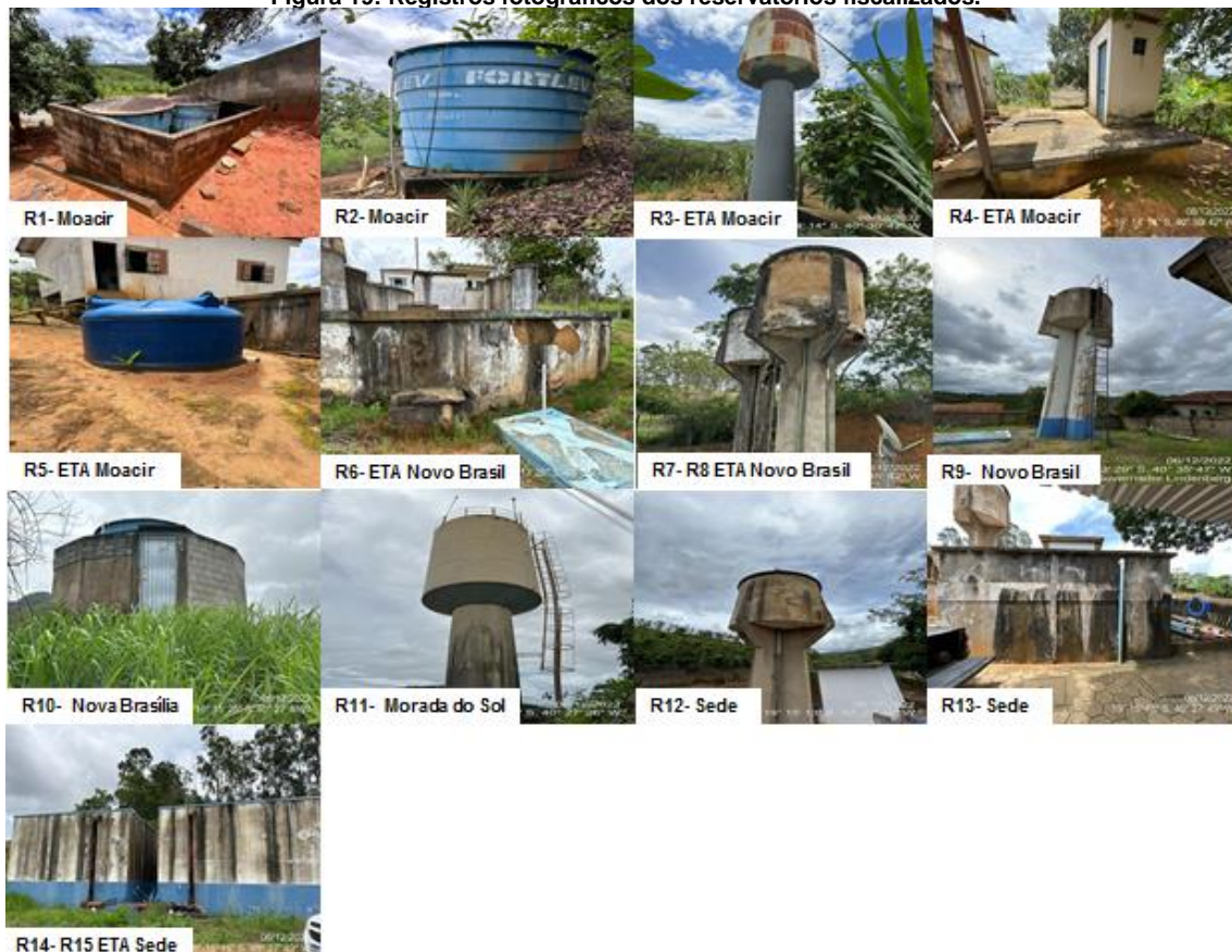
Figura 19: Registros fotográficos dos reservatórios fiscalizados.
