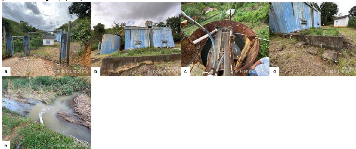
Figura 22: Registros fotográficos ETE Sede: a) Vista da entrada da ETE; b) Uasb; c) Tratamento secundário da ETE; d)Leito de secagem; e) Lançamento final
