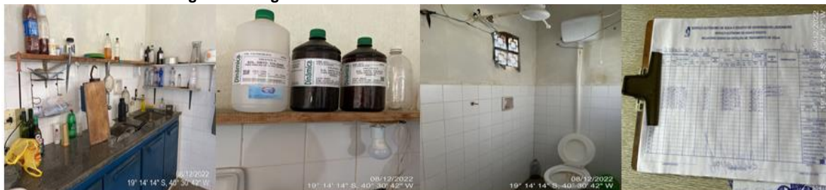
Figura 17: Registros das estruturas Laboratório da ETA Moacir Ávidos.
