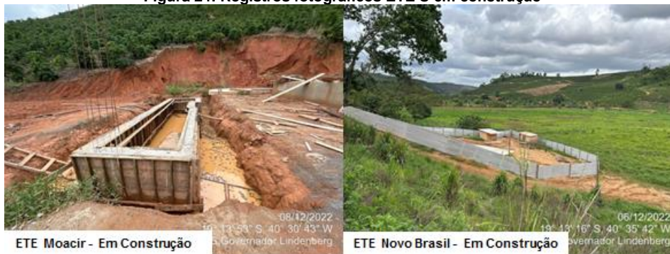
Figura 24: Registros fotográficos ETE'S em construção
