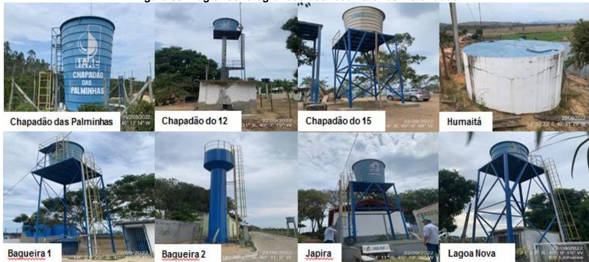
Figura 30: Registros fotográficos dos reservatórios vistoriados.
