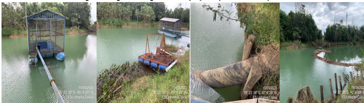
Figura 7: Registro Fotográfico da captação superficial Rio Pequeno.
