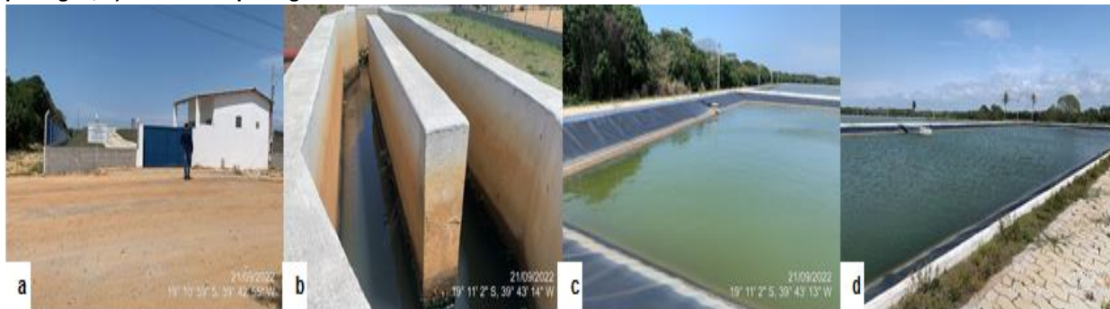
Figura 38: Registros fotográficos ETE Pontal do Ipiranga: a) Vista Geral da ETE; b) Tratamento primário; c) Tratamento por lagoa; d) Tratamento por lagoa.
