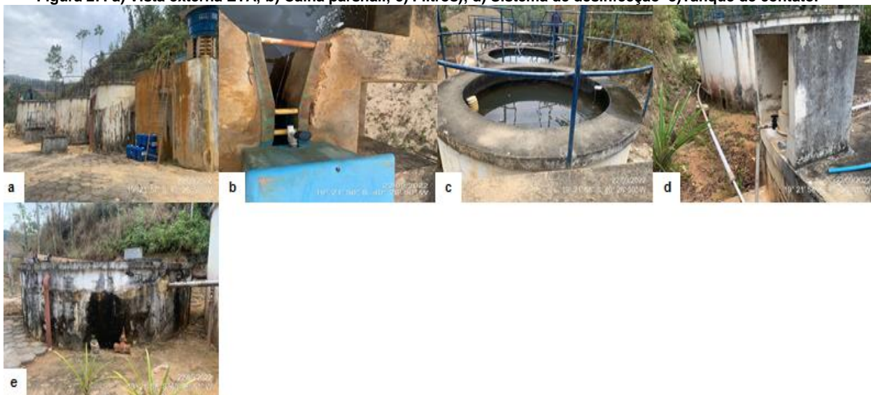
Figura 27: a) Vista externa ETA; b) Calha parshall; c) Filtros; d) Sistema de desinfecção e) Tanque de contato.
