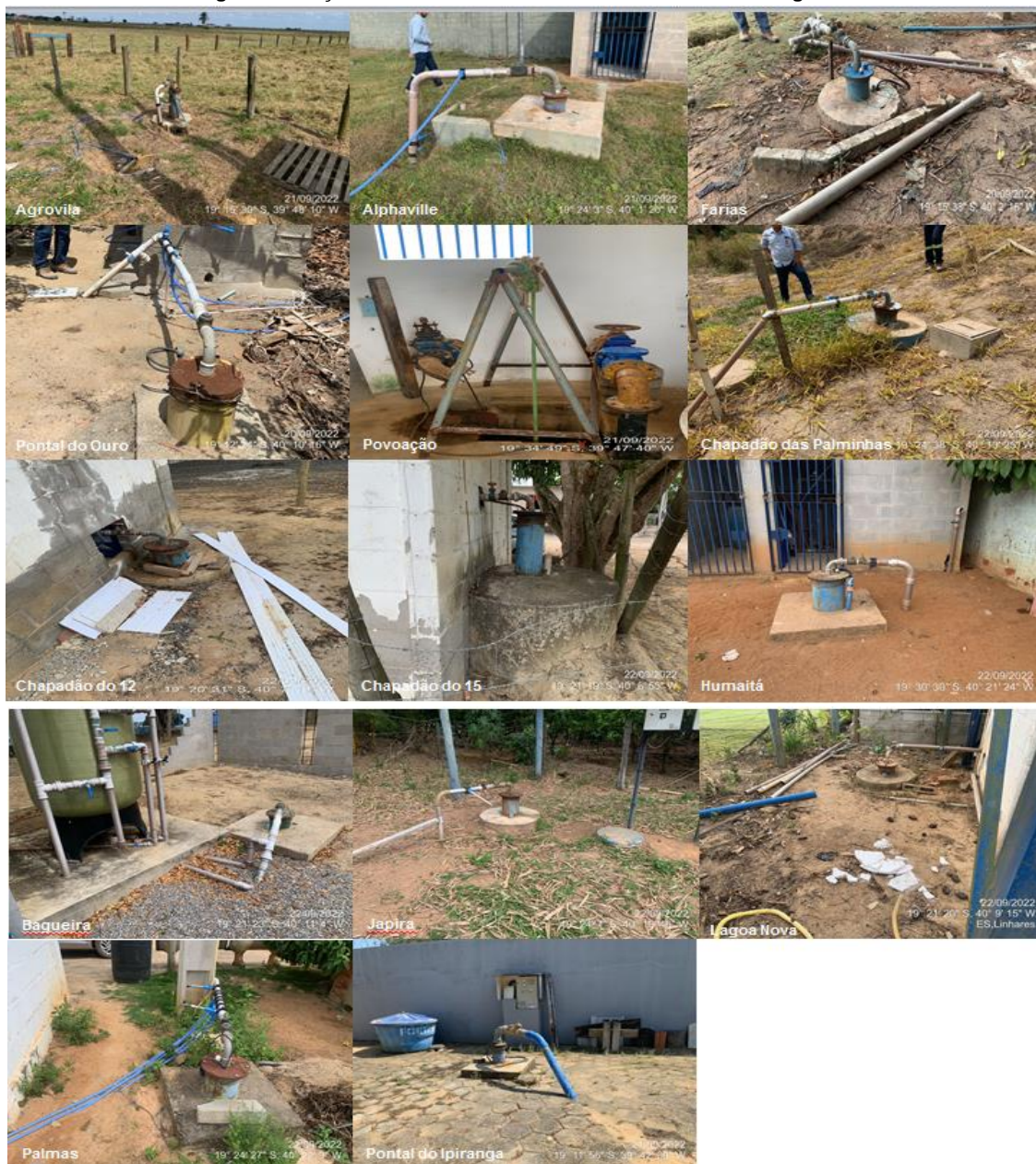
Figura 11: Poços vistoriados do sistema de abastecimento de água de Linhares
