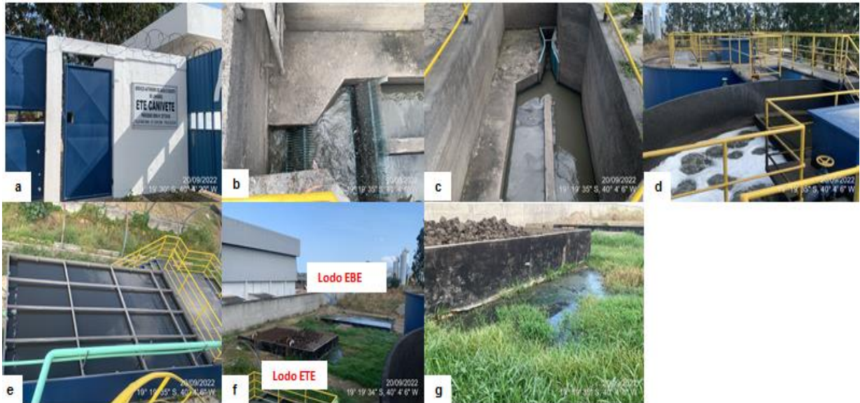
Figura 34: Registros fotográficos ETE Canivete: a) Vista da entrada da ETE; b) Tratamento preliminar por gradeamento; c) Caixa de areia; d) UASB; e) Decantador; f) Leitos de secagem; g) Leito de secagem com vazamento.
