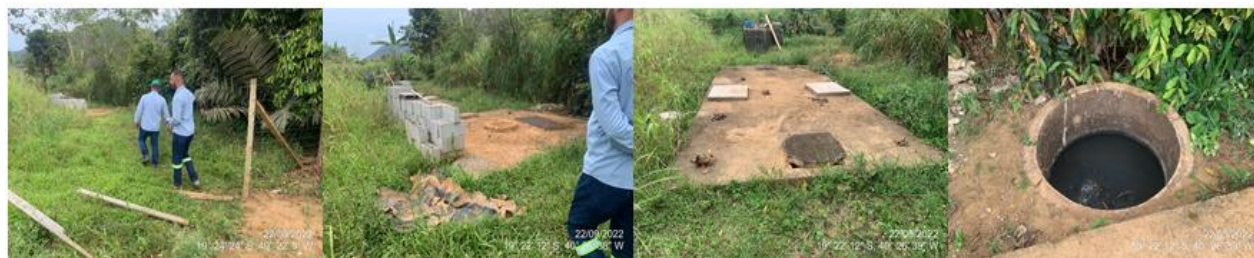
Figura 39: Registros fotográficos da Estação de tratamento de Esgoto São Rafael.
