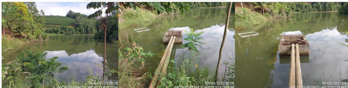
Figura 7: registro fotográfico da captação no Rio Iri-Timirim.
