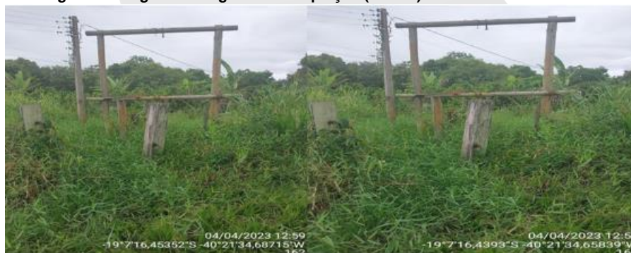
Figura 10: Registro Fotográfico da captação (inativa) São João do Tiradentes.
