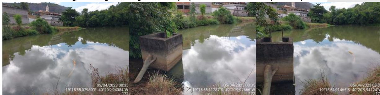
Figura 8: Registro fotográfico da captação no Rio Iri-Timirim Represa Baquetti.
