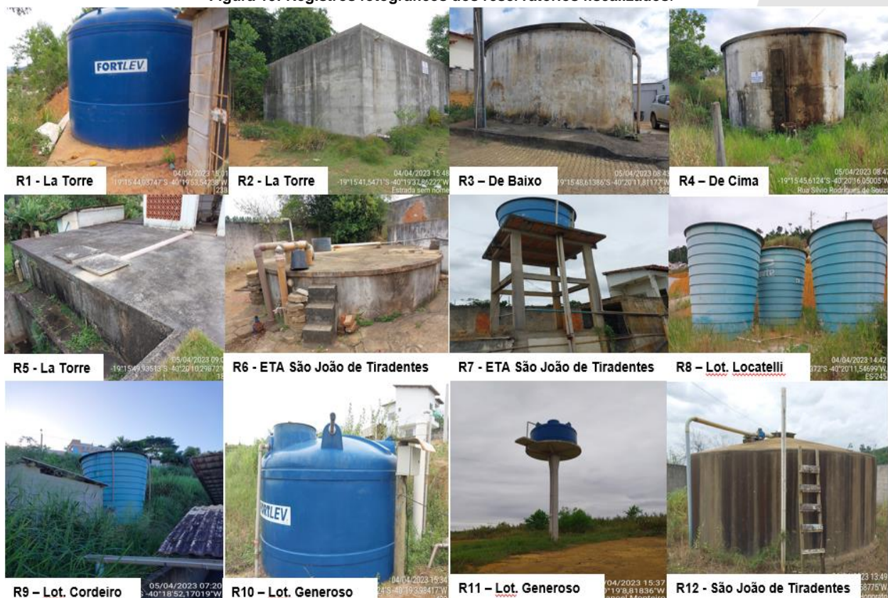
Figura 19: Registros fotográficos dos reservatórios fiscalizados.
