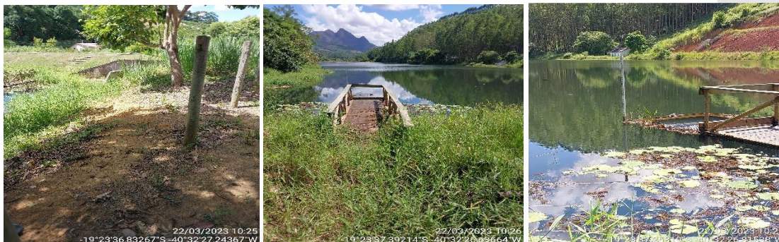
Figura 8: Registro Fotográfico da captação superficial Rio Liberdade.
