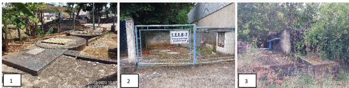
Figura 21: Registros fotográficos da Estação de bombeamento de esgoto.
