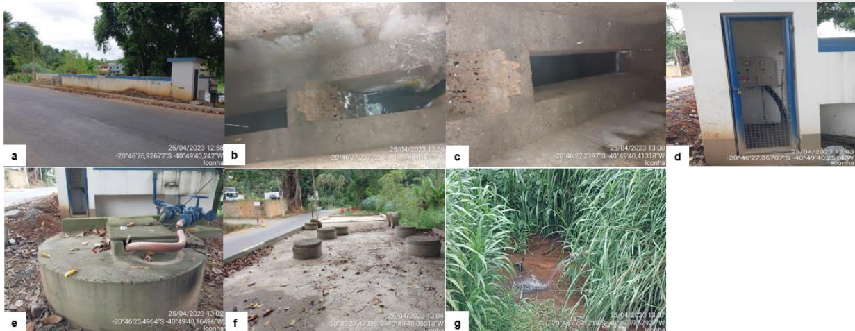
Figura 21: Registros fotográficos ETE Bom Destino: a) Vista da entrada da ETE; b) Gradeamento; c) Caixa de areia; d) Painel das bombas; e) Poço de sucção; f) Laje da ETE com tampas de acesso; g) Ponto de lançamento de efluente tratado.
