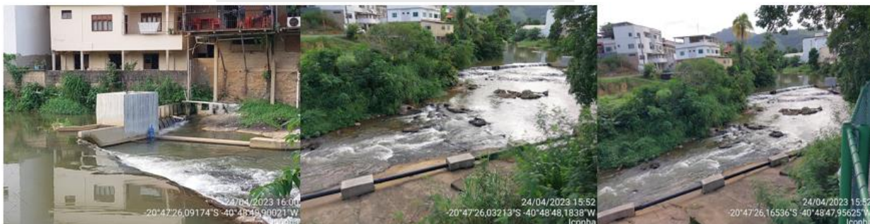
Figura 7: registro fotográfico da captação no Rio Iconha.
