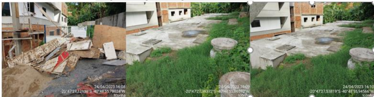
Figura 26: Registros fotográficos ETE Novo Horizonte.
