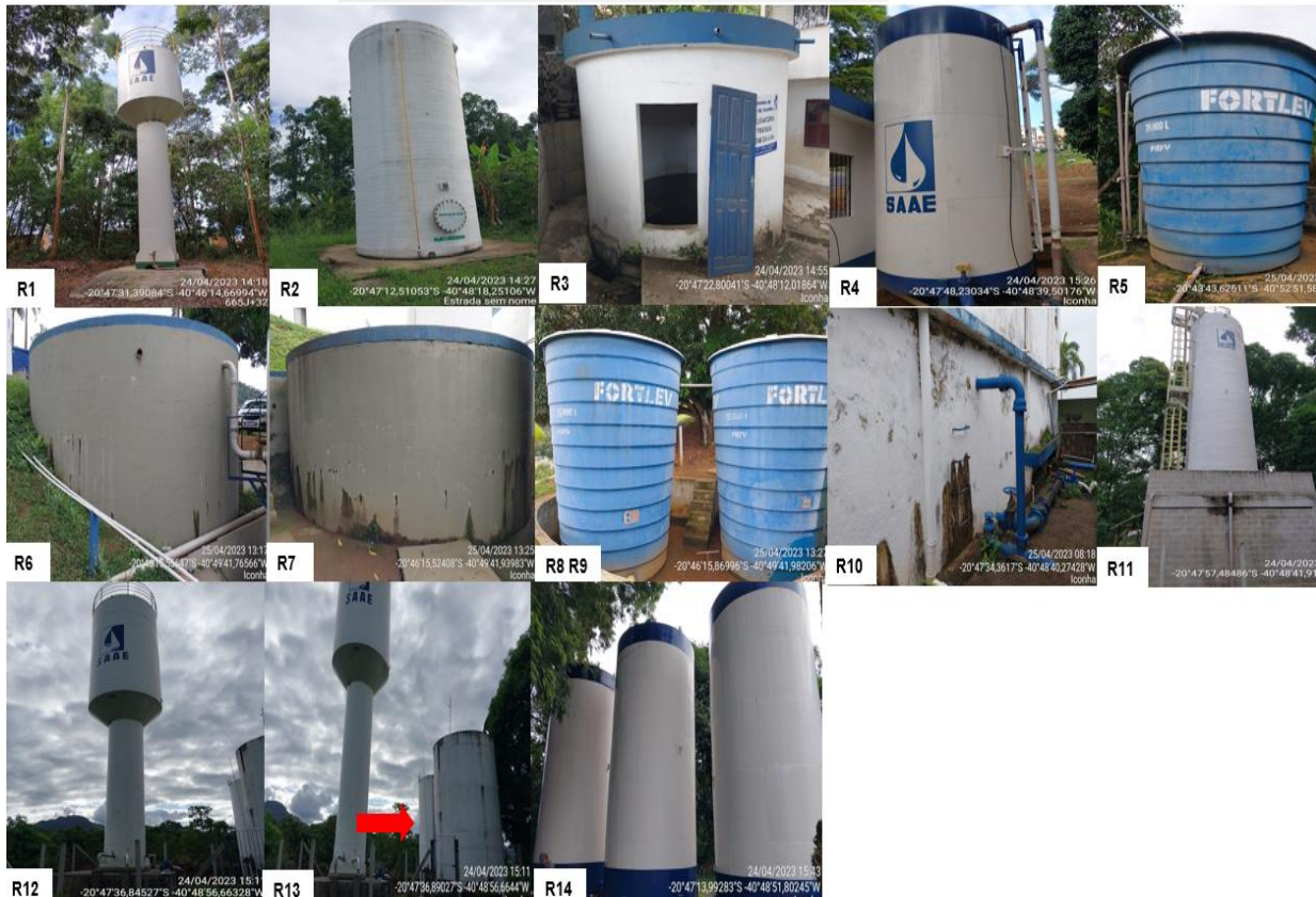
Figura 17: Registros fotográficos dos reservatórios fiscalizados.
