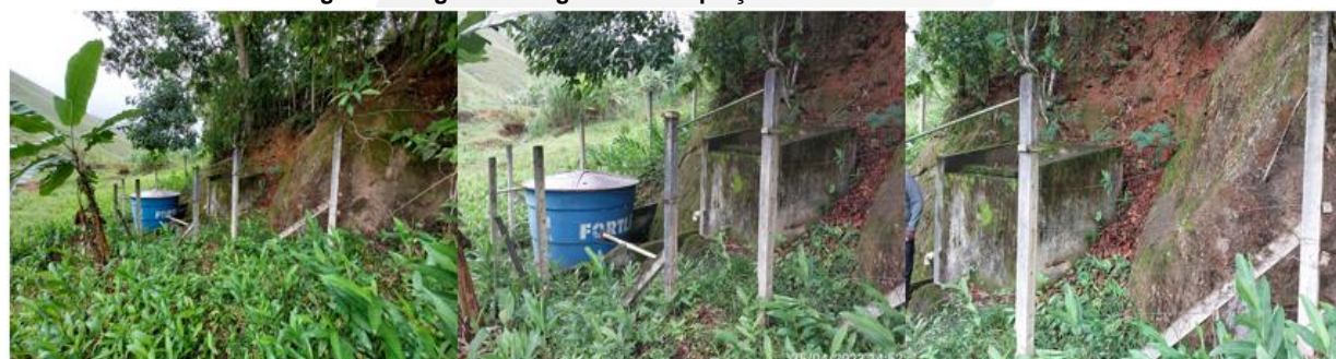
Figura 9: Registro Fotográfico da captação Nascente Santo Antônio.
