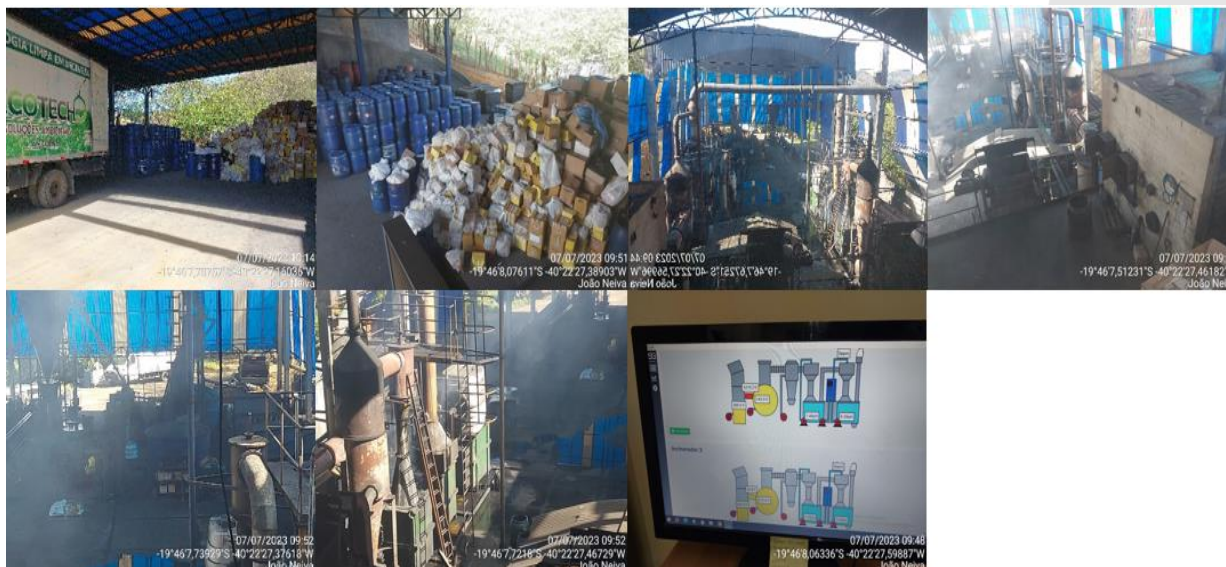
Figura 14 – Registro fotográficos das estruturas do incinerador:
