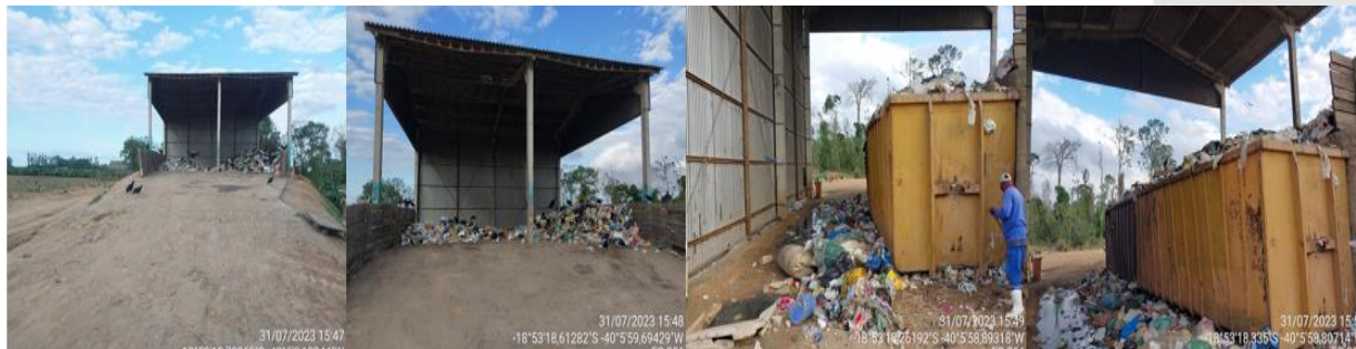
Figura 9 – Registros fotográficos da área de Transbordo
