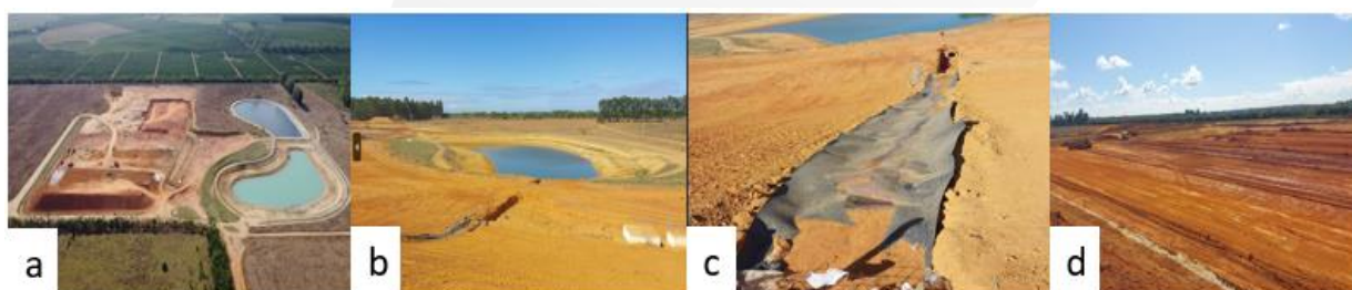
Figura 11 – Registros Fotográficos da estrutura do aterro sanitário de Linhares. a) Vista geral do aterro; b) Vista da Lagoa para armazenamento temporário de chorume; c) Vista da canaleta de direcionamento do chorume; d) Vista da área de ampliação do aterro;
