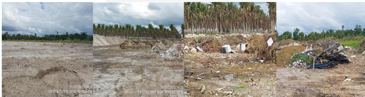
Figura 16 – Registros Fotográficos do aterro Destinação Final de RCC.
