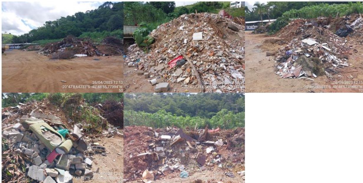
Figura 9 – Registros fotográficos do local de destinação final de RCC e Volumosos.
