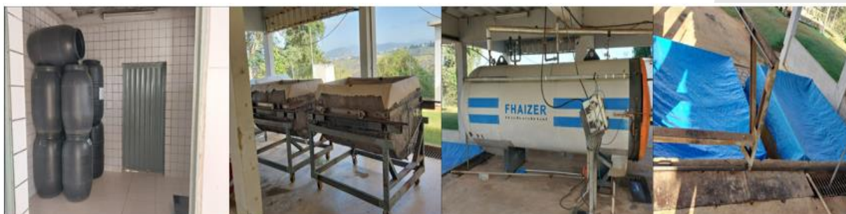
Figura 5 – Registro fotográficos das estruturas da autoclave:
