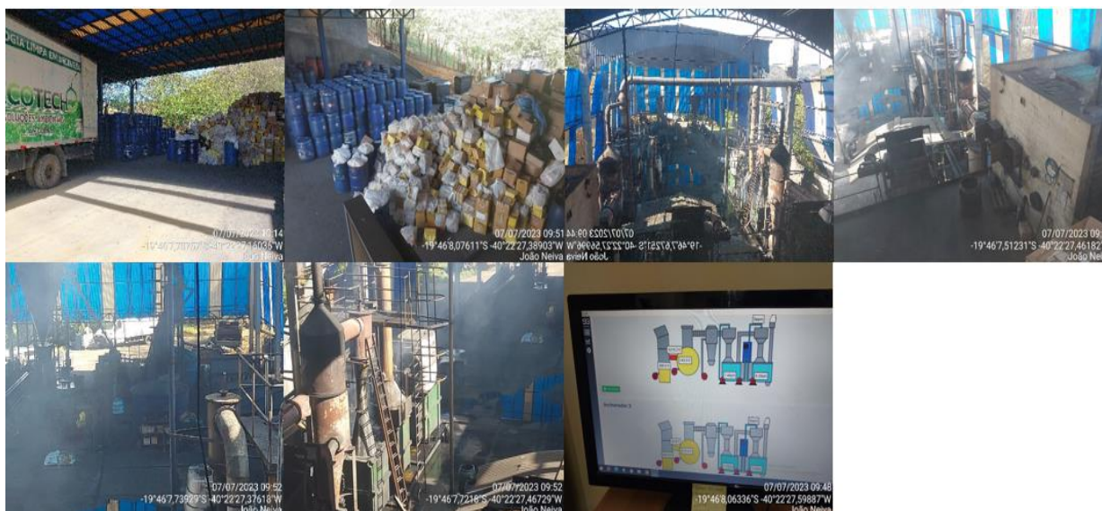
Figura 13 – Registro fotográficos das estruturas do incinerador:
