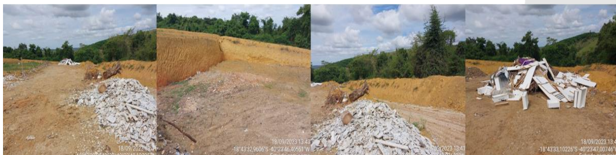
Figura 15 – Registros Fotográficos do aterro Destinação Final de RCC.
