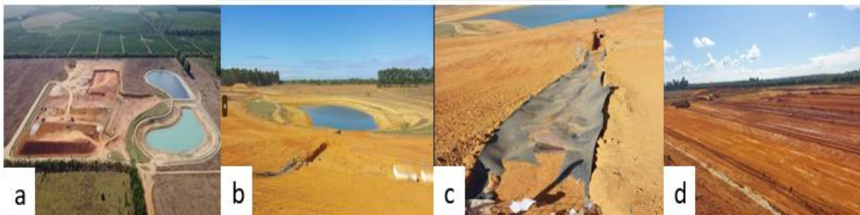
Figura 10 – Registros Fotográficos da estrutura do aterro sanitário de Linhares. a) Vista geral do aterro; b) Vista da Lagoa para armazenamento temporário de chorume; c) Vista da canaleta de direcionamento do chorume; d) Vista da área de ampliação do aterro;
