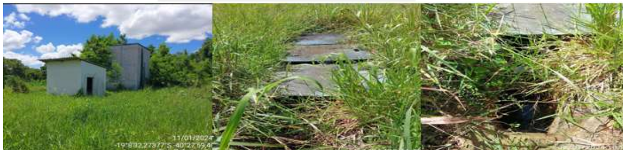
Figura 25: Registros fotográficos da ETE Morelo.
