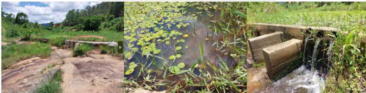
Figura 8: Registro fotográfico da captação no Córrego Paraíba.
