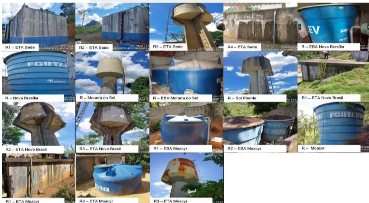
Figura 20: Registros fotográficos dos reservatórios fiscalizados.
