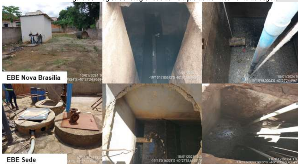
Figura 30: Registros fotográficos da Estação de bombeamento de esgoto.
