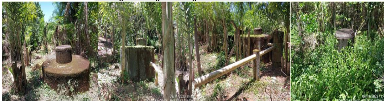
Figura 30: Registros fotográficos da ETE Ibitiruí.
