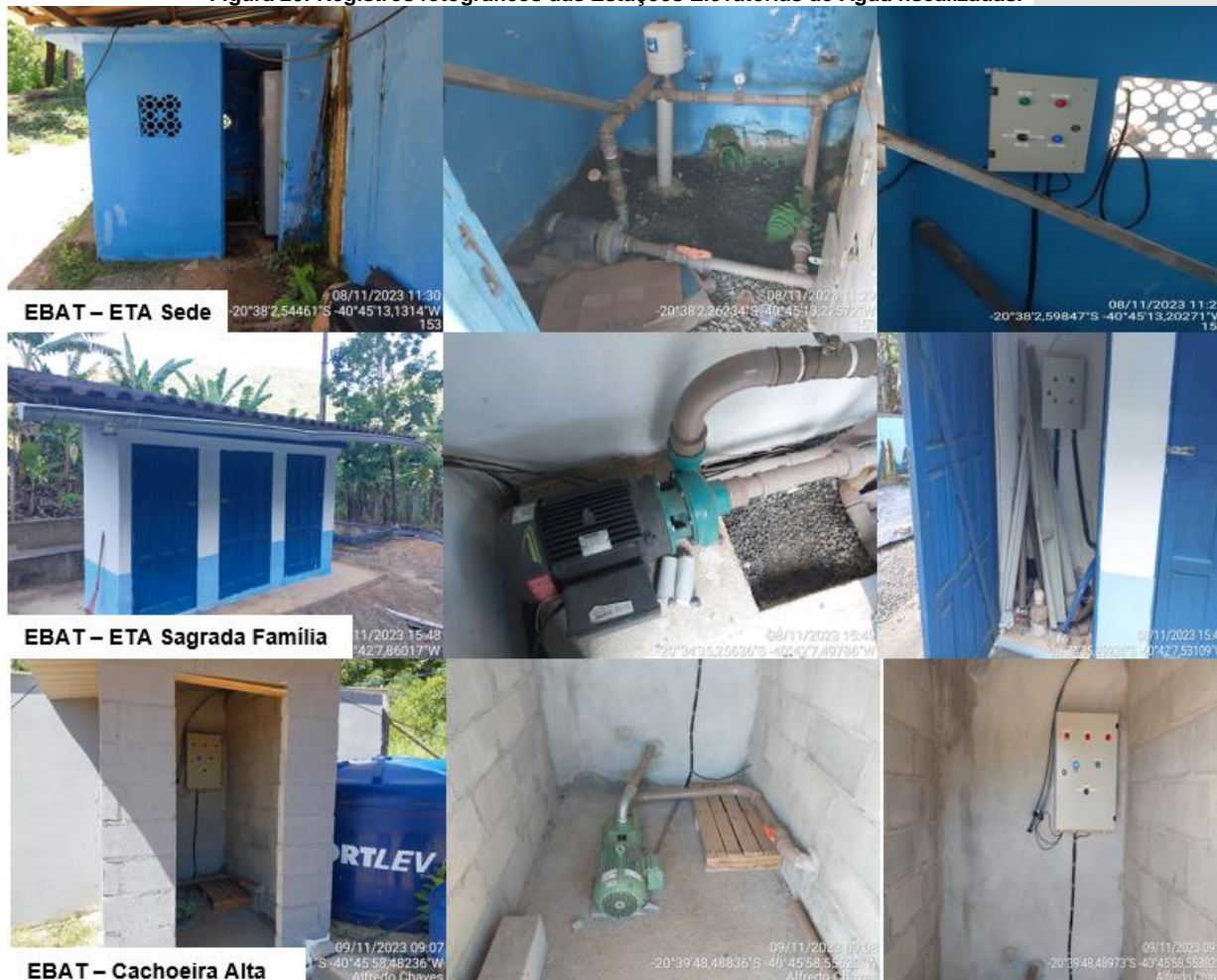
Figura 20: Registros fotográficos das Estações Elevatórias de Água fiscalizadas.
