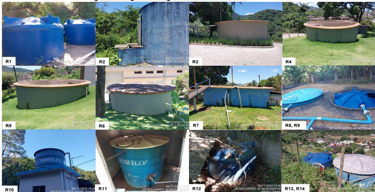
Figura 18: Registros fotográficos dos reservatórios fiscalizados.
