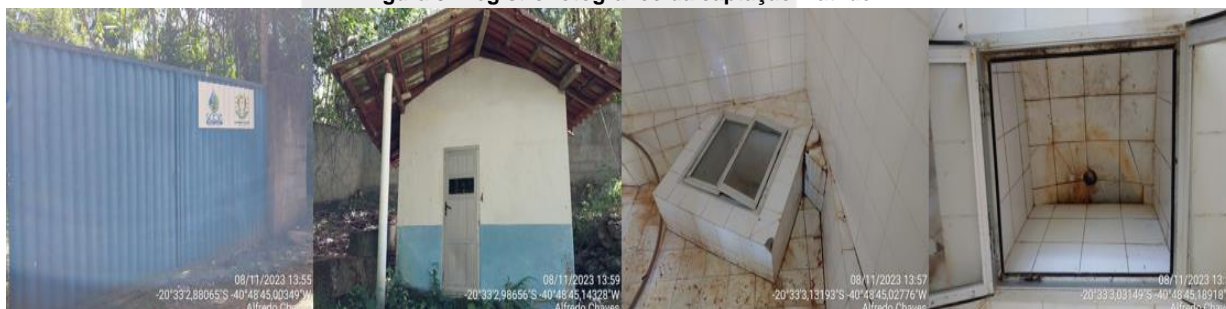
Figura 8: Registro fotográfico da captação Matilde.
