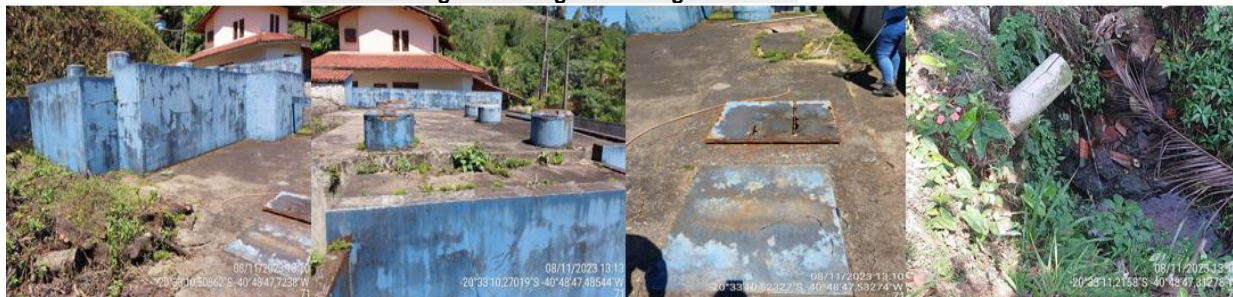
Figura 28: Registros fotográficos da ETE Matilde.
