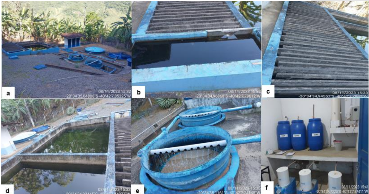
Figura 15: Vistas da ETA Sagrada Família: a) Vista geral da ETA; b) Chegada d'água bruta; c) floculador; d) decantador; e) filtros; f) desinfecção
