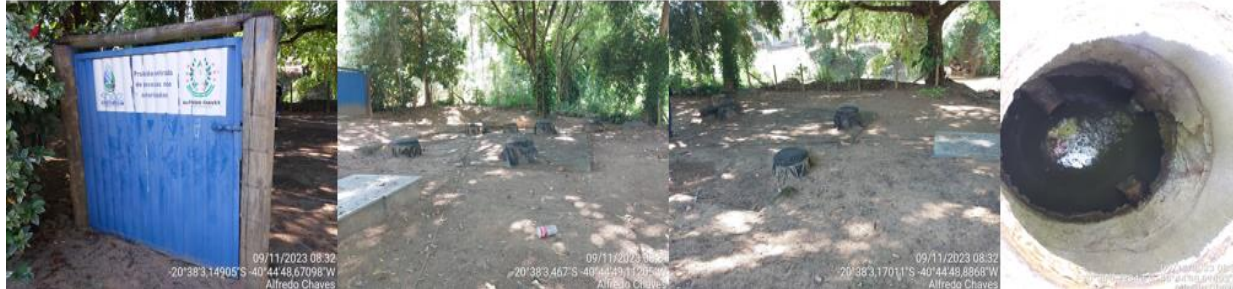
Figura 27: Registros fotográficos da ETE Imigrantes.
