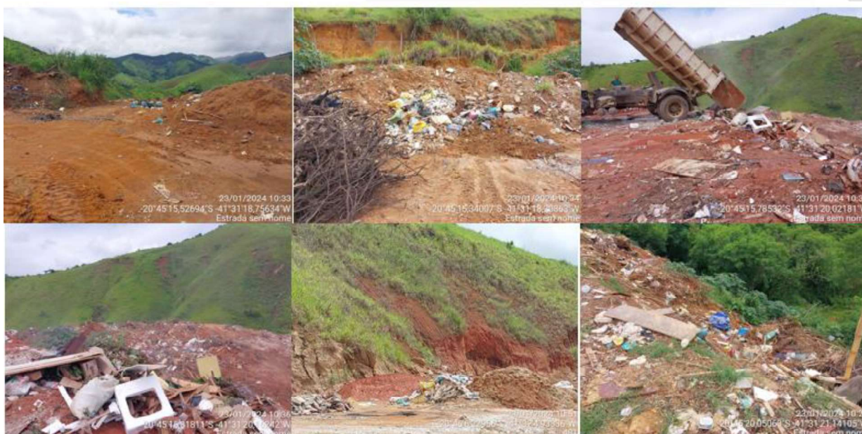
Figura 12 – Registros Fotográficos do aterro Destinação Final de RCC.
