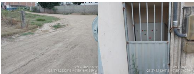
Figura 37: Registros fotográficos da Estação de bombeamento de esgoto Santa Rita II.
