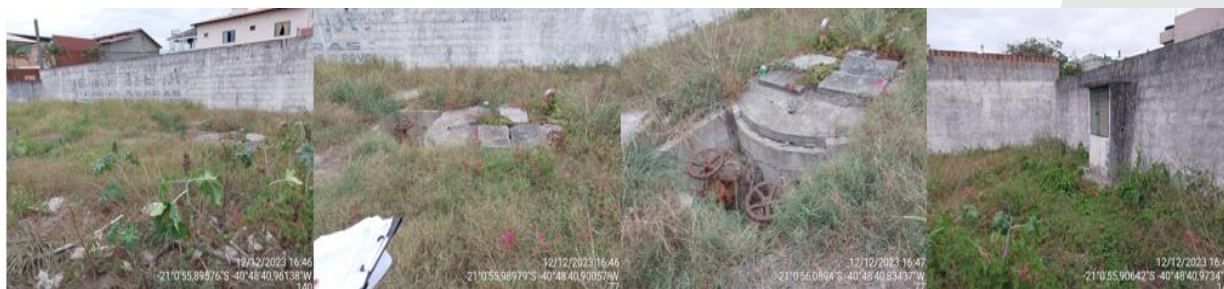
Figura 59: Registros fotográficos da Estação de bombeamento de esgoto Vila Militar.
