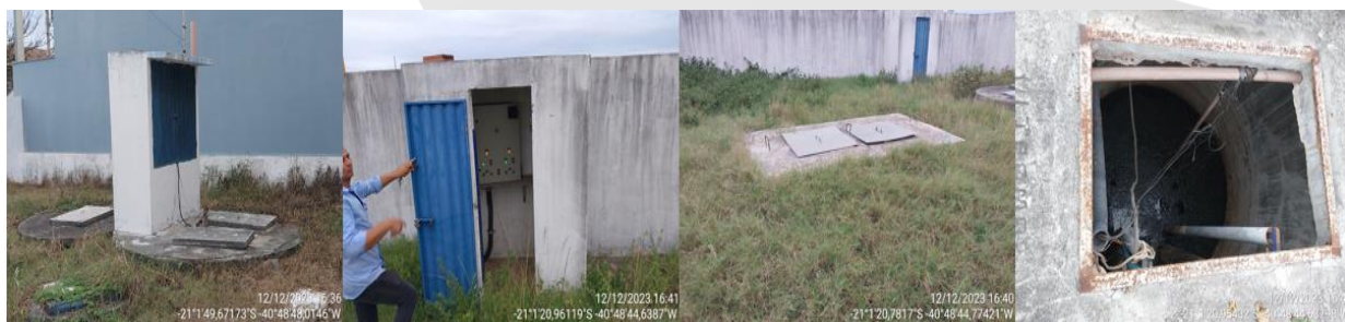
Figura 46: Registros fotográficos da Estação de bombeamento de esgoto Genesis Bitencurt.
