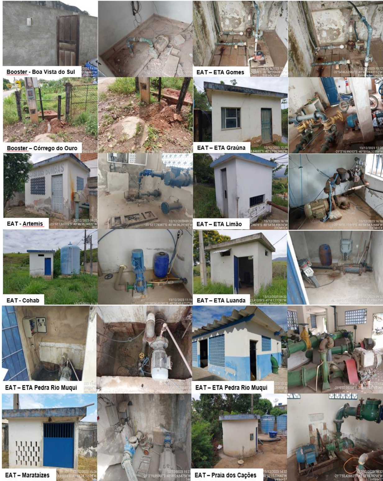
Figura 31: Registros fotográficos das Estações Elevatórias de Água vistoriadas.
