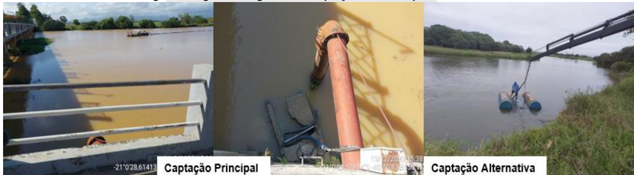
Figura 6: registro fotográfico da captação no Rio Itapemirim - Sede.
