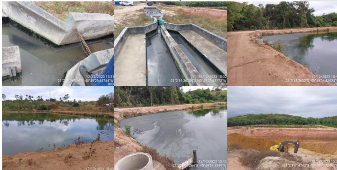
Figura 34: Registros fotográficos da ETE Ilmenita.
