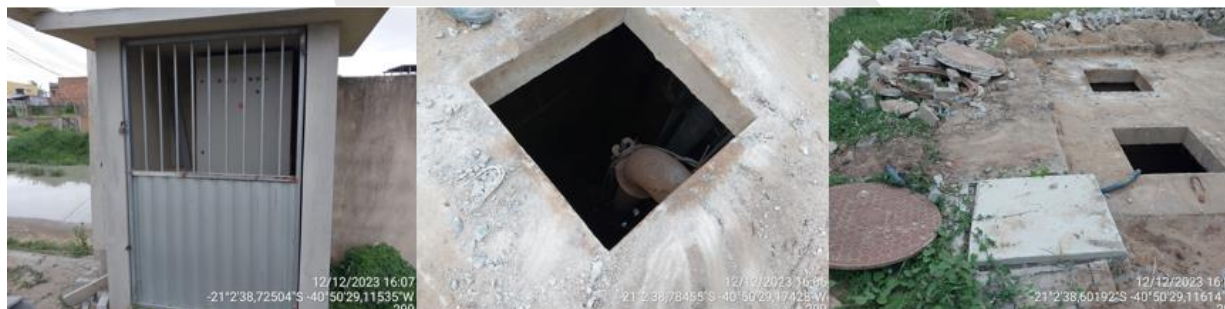
Figura 36: Registros fotográficos da Estação de bombeamento de esgoto Santa Rita I.
