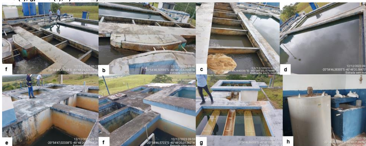
Figura 20: Vistas da ETA Gomes: a) Vista geral da ETA; b) Calha Parshall; c) floculador; d) decantador; e) filtro (1); f) filtro (2); g) filtro (3); h) desinfecção.
