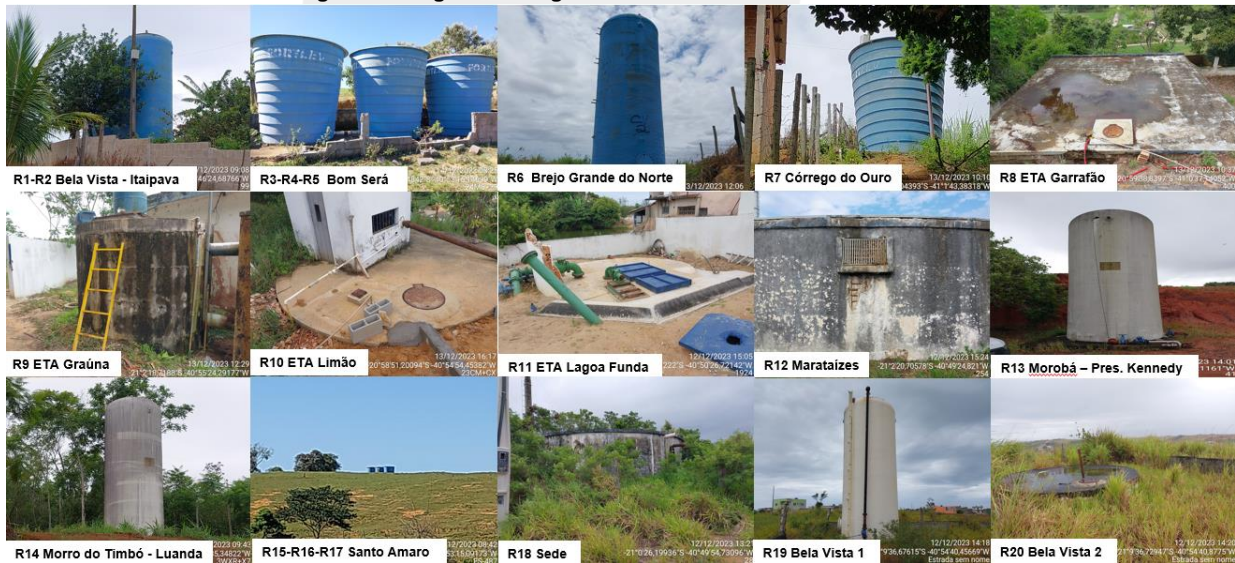
Figura 30: Registros fotográficos dos reservatórios vistoriados.
