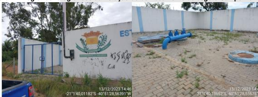
Figura 41: Registros fotográficos da Estação de bombeamento de esgoto Campo Acima IIII.
