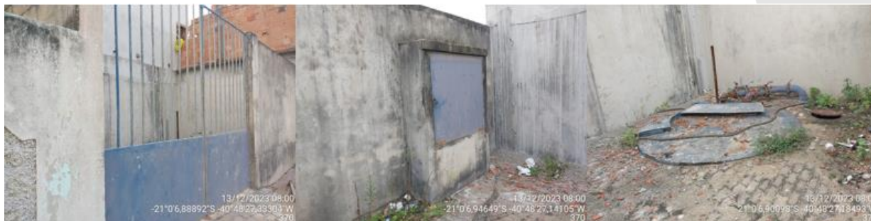
Figura 52: Registros fotográficos da Estação de bombeamento de esgoto Pontal.
