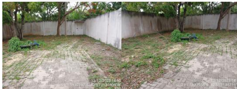
Figura 45: Registros fotográficos da Estação de bombeamento de esgoto Edgar.
