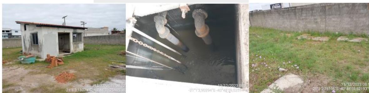
Figura 43: Registros fotográficos da Estação de bombeamento de esgoto Candinha.
