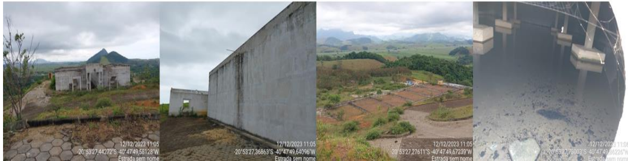
Figura 28: Vistas da ETA Gomes desativada.
