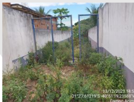
Figura 51: Registros fotográficos da Estação de bombeamento de esgoto Leão.
