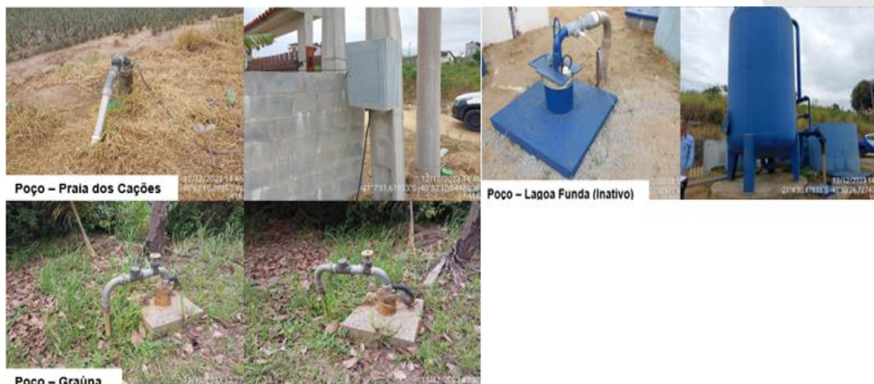
Figura 14: Registro Fotográfico dos poços.
