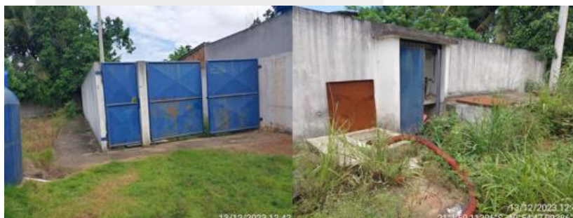
Figura 48: Registros fotográficos da Estação de bombeamento de esgoto Graúna I.
