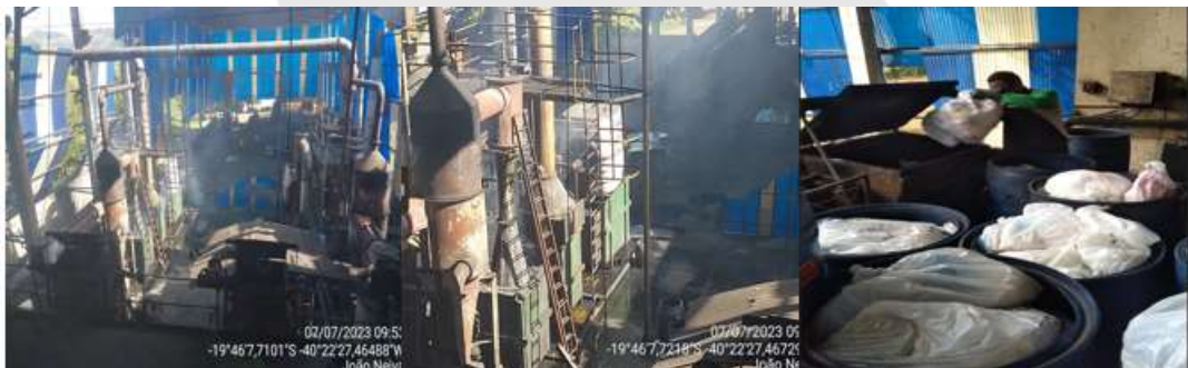
Figura 10 – Registros Fotográficos das estruturas do incinerador.
