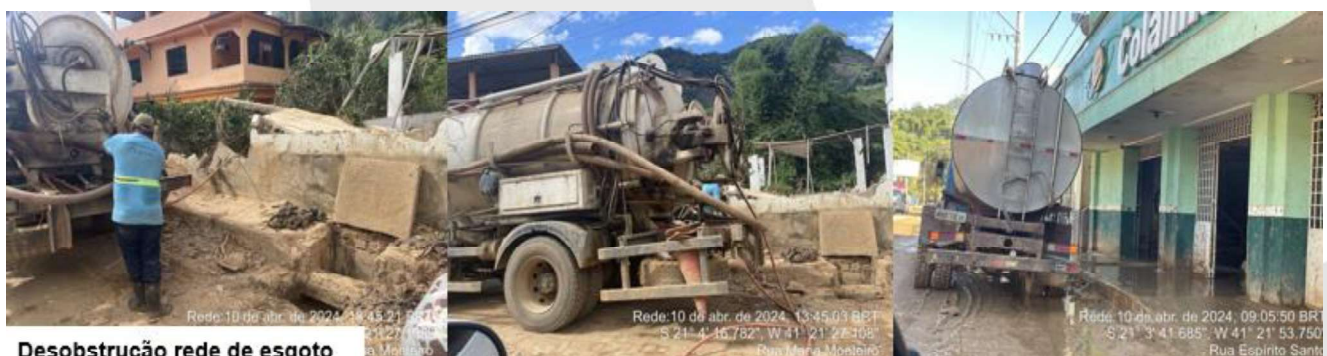
Figura 11: Desobstrução da rede de esgoto através de caminhão hidrojato.
