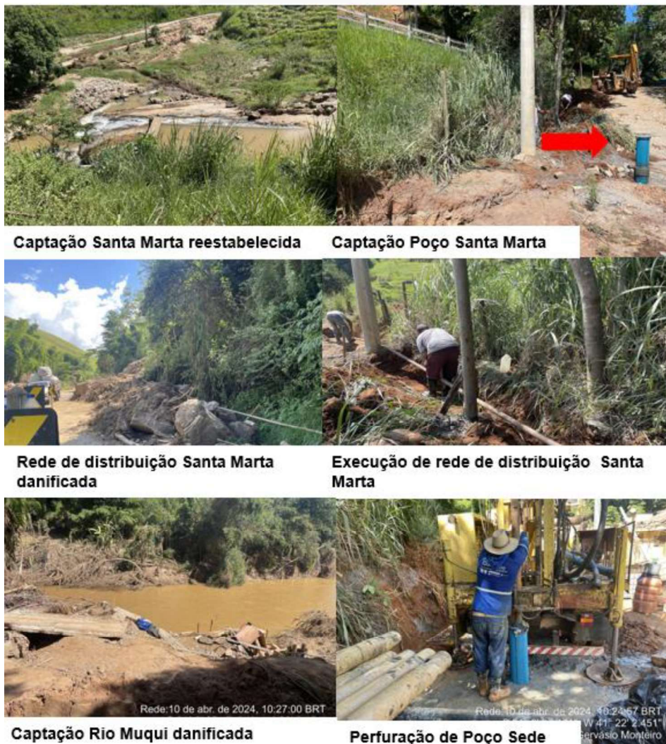
Figura 2: Captação Santa Marta, execução de rede para abastecimento do Bairro Santa Marta e perfuração de poço Sede.
