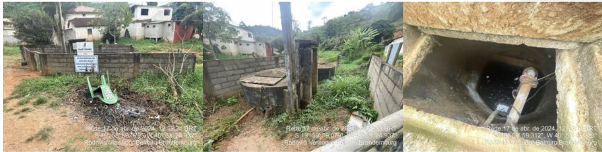
Figura 32: Registros fotográficos EBE Alto Jatibocas.
