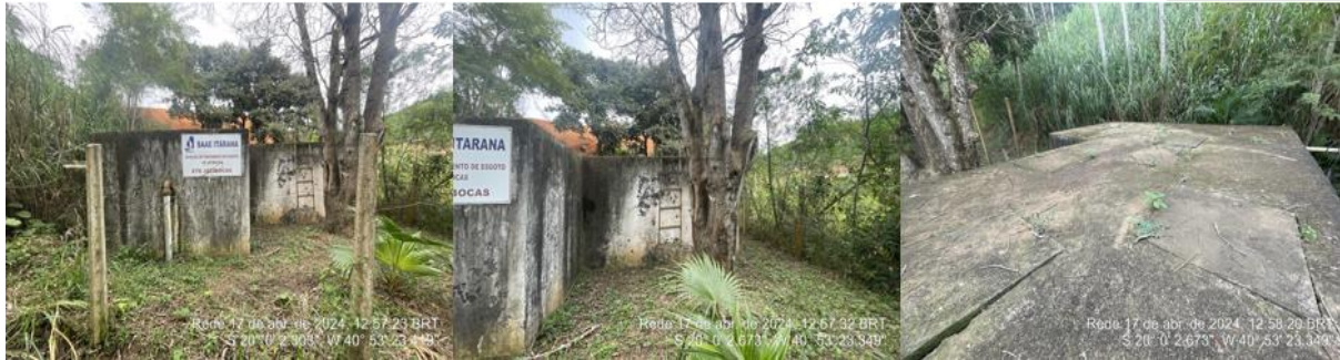
Figura 27: Registros fotográficos ETE Jatibocas.
