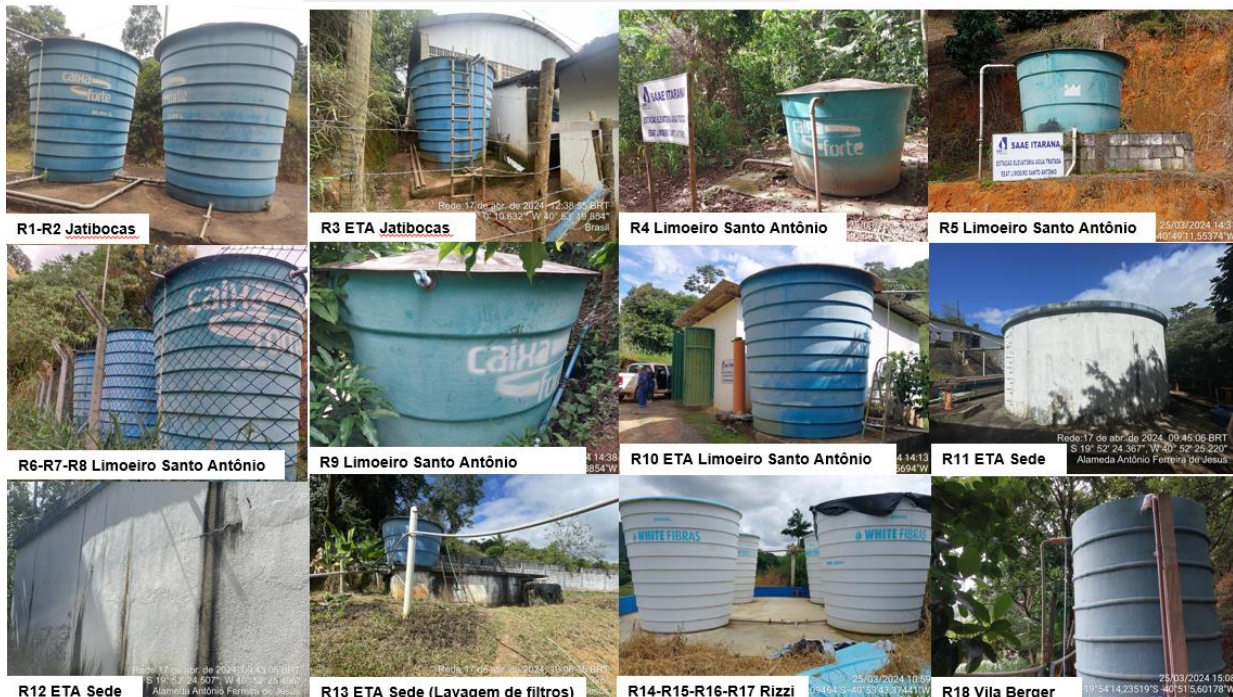
Figura 21: Registros fotográficos dos reservatórios fiscalizados.
