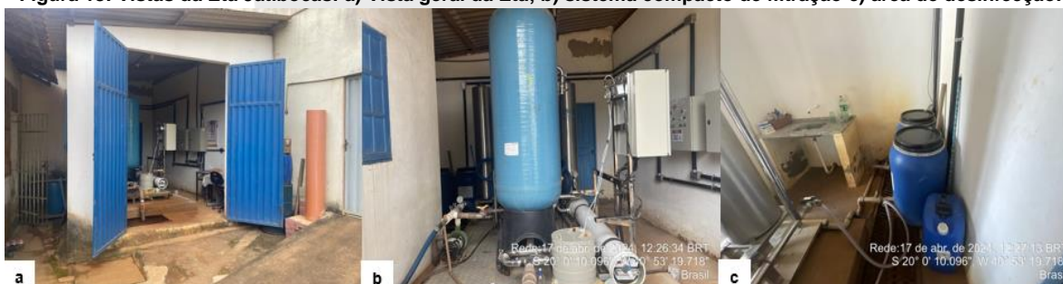
Figura 18: Vistas da Eta Jatibocas: a) Vista geral da Eta; b) sistema compacto de filtração c) área de desinfecção.
