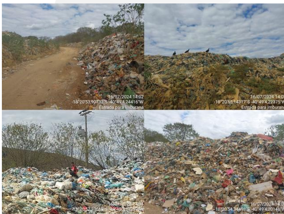
Figura 8 – Registros Fotográficos das estruturas do lixão municipal de Ecoporanga.
