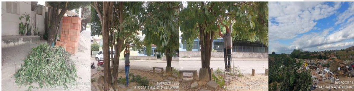
Figura 7 – Registros Fotográficos acondicionamento, execução do serviço de poda e o local de destinação final
