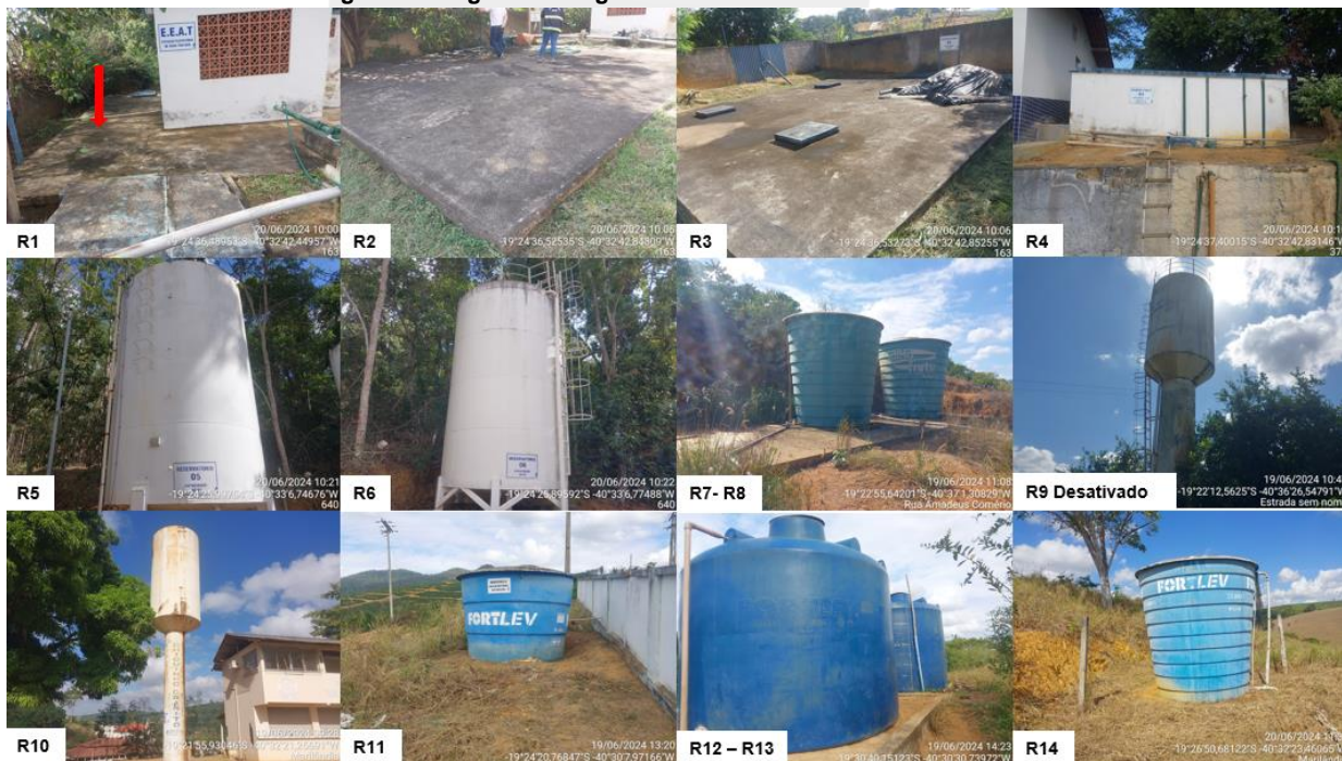
Figura 17: Registros fotográficos dos reservatórios fiscalizados.
