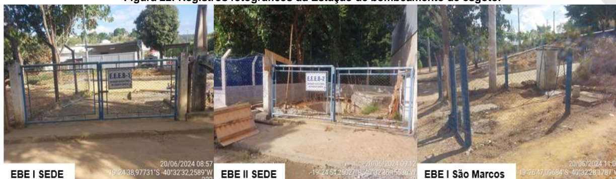
Figura 22: Registros fotográficos da Estação de bombeamento de esgoto.
