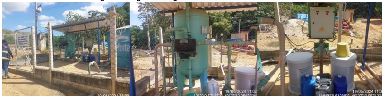
Figura 13: Registros fotográficos da ETA Patrimônio do Rádio.
