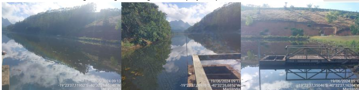
Figura 8: Registro Fotográfico da captação superficial Rio Liberdade.
