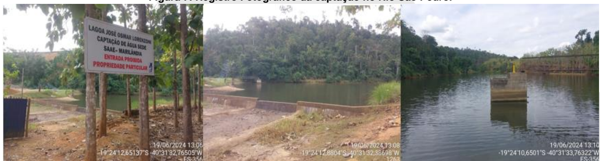
Figura 7: Registro Fotográfico da captação no Rio São Pedro.
